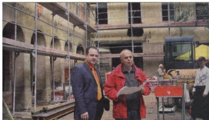
Vorstand Thomas Smektalla (l.) und Bauleiter Udo Bräunlich vor der eingerüsteten Immobilie. Den Richtspruch hielt Zimmermeister Jürgen Feller aus Sölmnitz. (Foto: OTZ/Erika Baumann)
